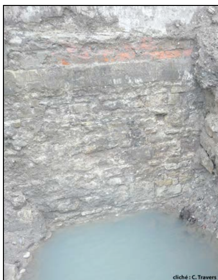
fig. 55 : Fondation du mur de soutènement Ouest de la terrasse du Quinconce – Extrémité Est du sondage S.XXI
