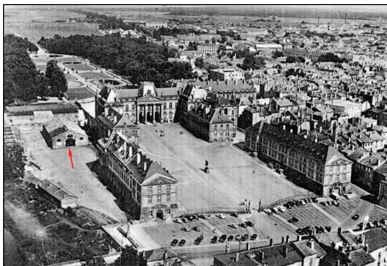
fig. 116 : La cour du Rocher dans les années 1950-1960 (garage Citroën) – Cliché aérien, documentation Mr Schwender
