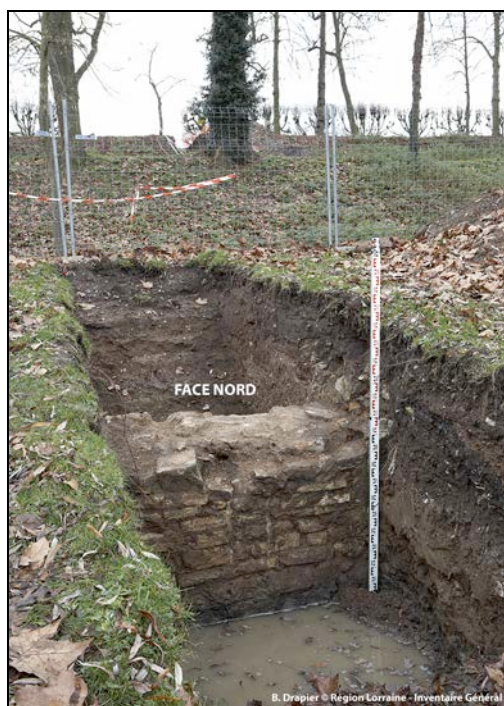
fig. 30 : Fondation du mur Sud du canal (face Nord) repérée dans le sondage S.XXII
