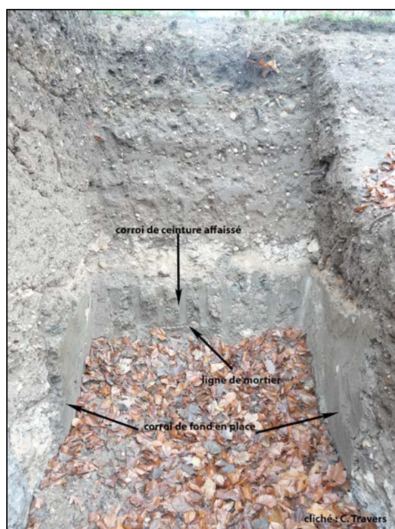
fig. 26 : Vestiges du bassin de la salle des Tilleuls – Extrémité Sud du sondage S.VI
