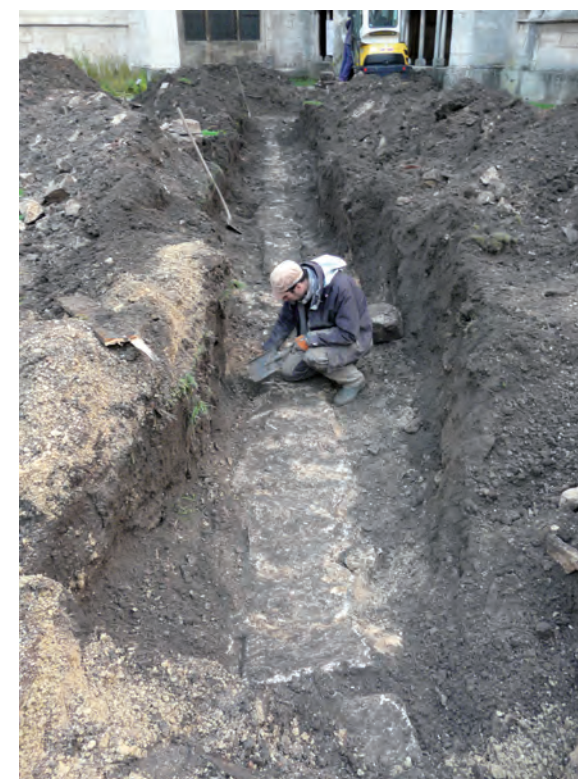
fig. 7 : Canalisation C.8 (cliché : C. Travers)
