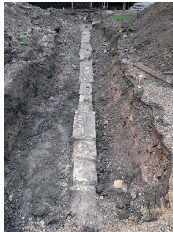
fig. 2 : Canalisation C.2 (cliché : C. Travers)
