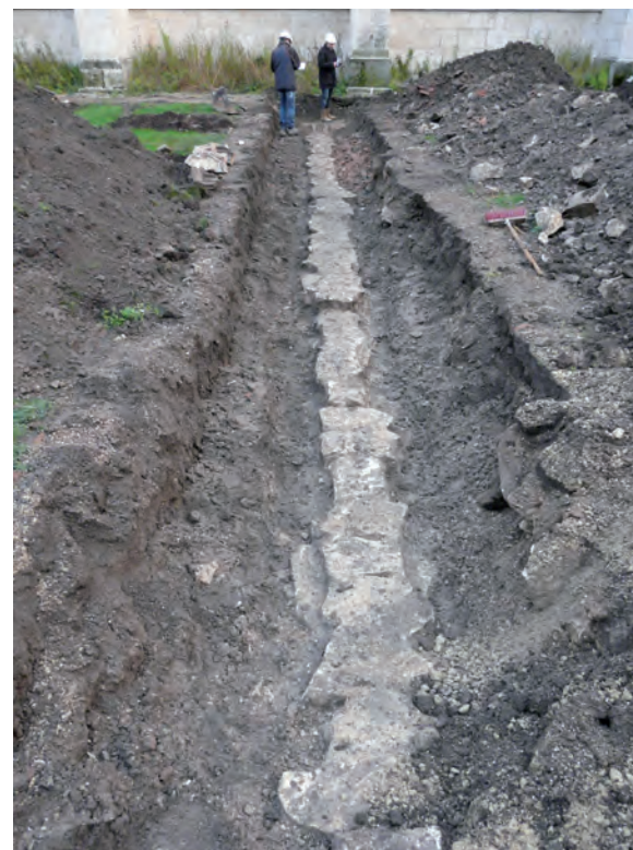
fig. 6 : Canalisation C.7 (cliché : C. Travers)
