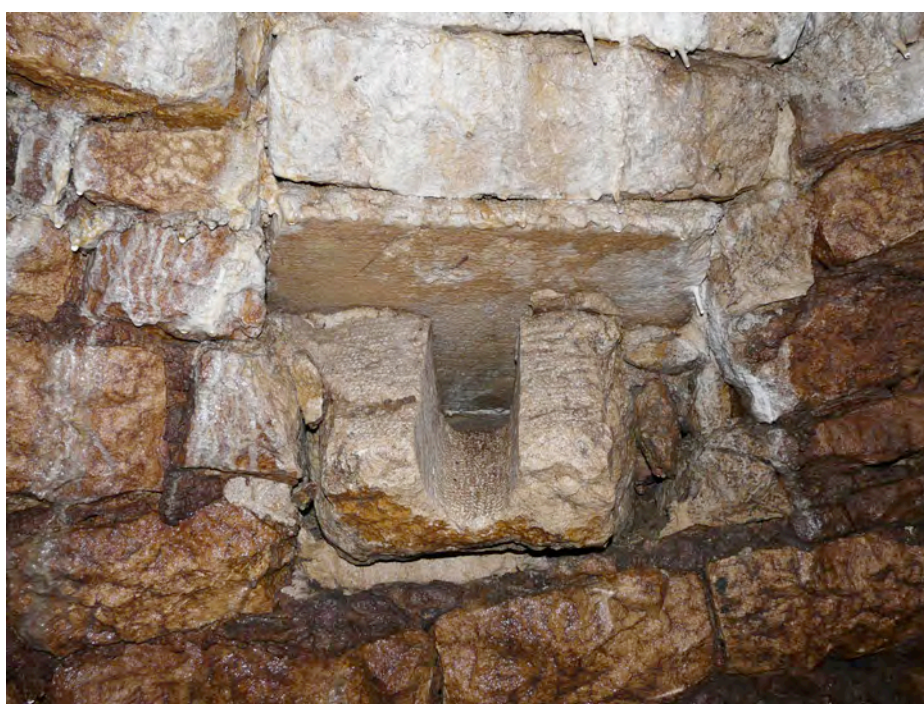
fig. 23 : Exutoire de la canalisation C.3 (angle S/O du cloître) © C. Travers – Archéoverde
