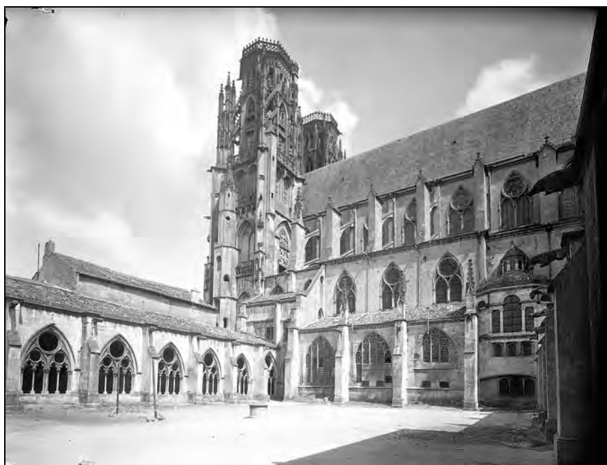
fig. 15 : Le cloître vers 1925 – Cliché de G.-L. ARLAUD (photographe), Flanc sud, cloître et salle capitulaire , vers 1925 – © Ministère de la Culture – Médiathèque de l'architecture et du patrimoine – Diffusion RMN (source internet : www.photo.rmn.fr )
