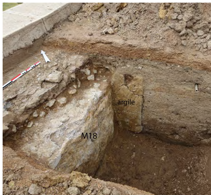
fig. 41 : Le mur M18 et son corroi d'argile US 178/179 observés dans le sondage S.XIII © C. Travers
