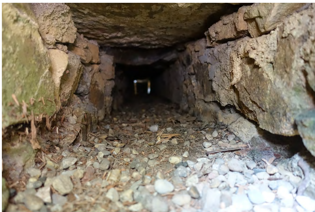
fig. 67 : Conduit intérieur de la canalisation M23 © C. Travers
