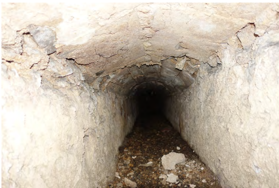
fig. 64 : Conduit intérieur de la canalisation M22 © C. Travers
