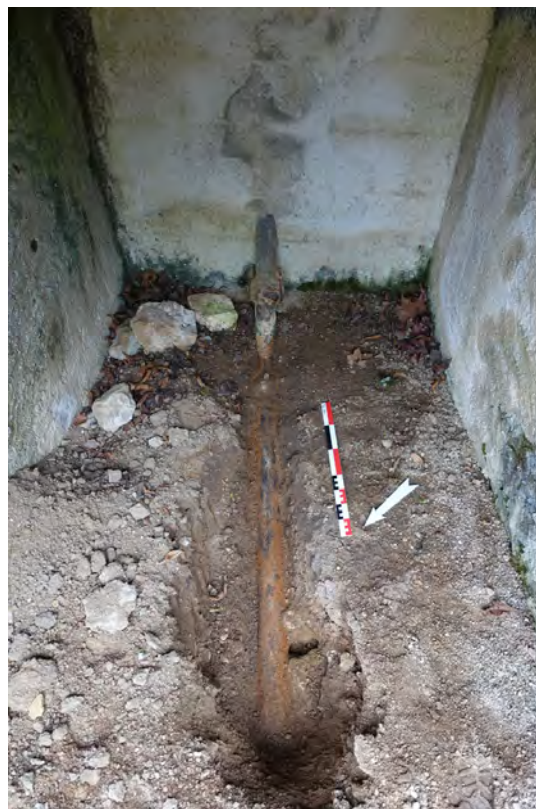
fig. 48 : Canalisation en fonte mise au jour dans la niche du potager © C. Travers
