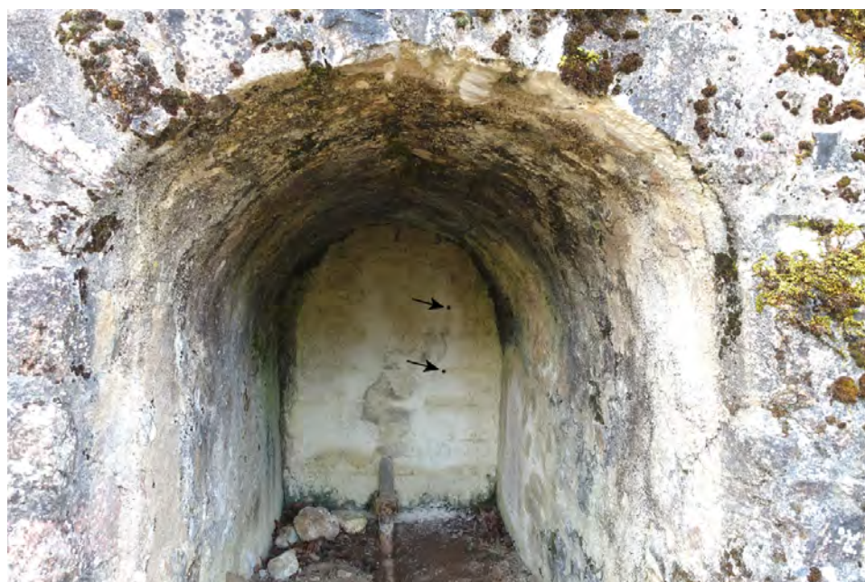
fig. 49 : Forages effectués dans le mur de fond de la niche du potager © C. Travers
