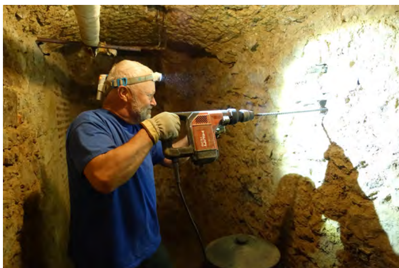
fig. 12 : Marc Noël (société XPOINTO) effectuant un forage dans le mur SO de la pièce aveugle située dans les caves du château © C. Travers
