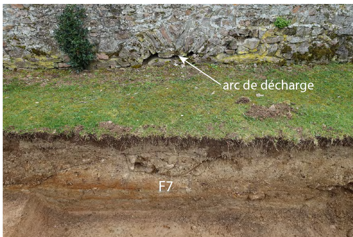
fig. 33 : Drain F7 observé dans la coupe E-O du sondage S.XI © C. Travers
