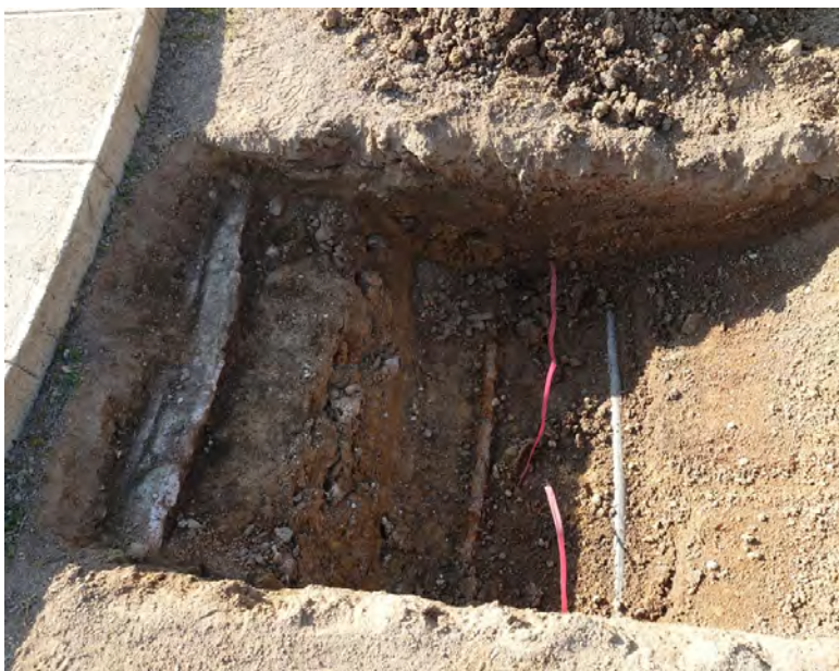
fig. 50 : Réseaux d'arrosage successifs (fonte et PVC gris) mis au jour dans le sondage S.XIV © C. Travers
