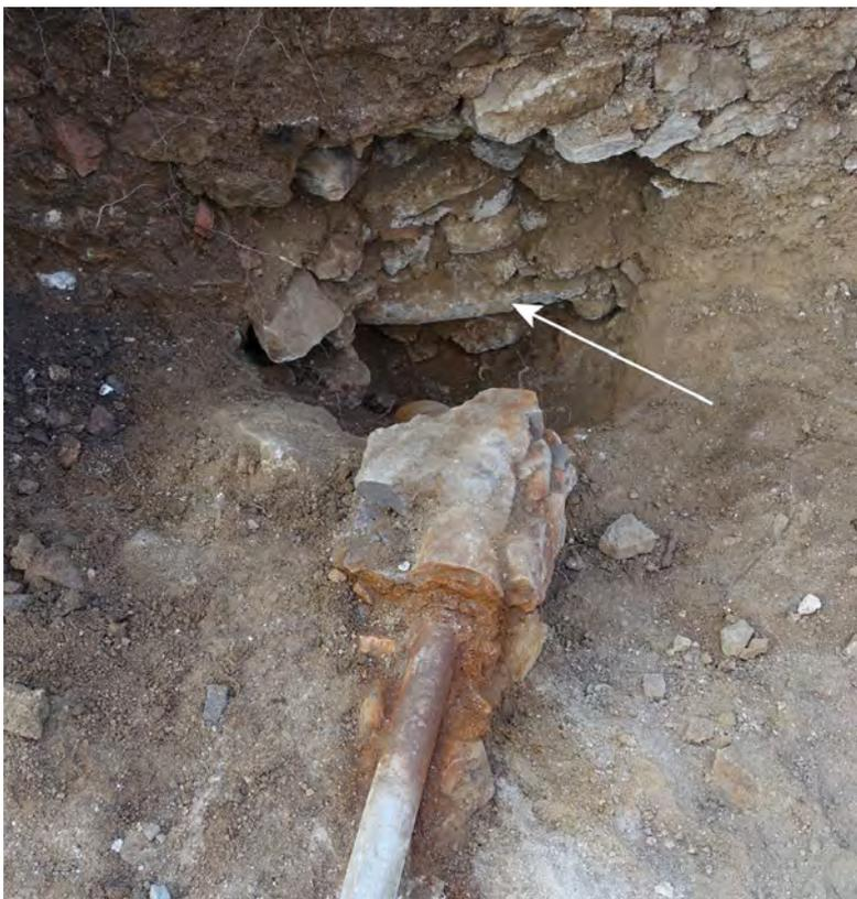
fig. 26 : Pierre plate située au-dessus de l'ouverture pratiquée dans le mur de fondation de la grille © C. Travers
