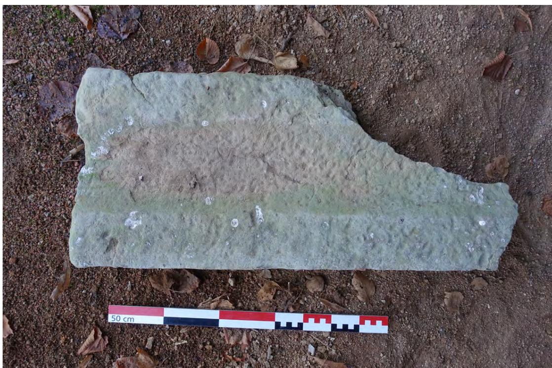
fig. 21 : Élément de rigole en pierre fracturé vu de dessus © C. Travers
