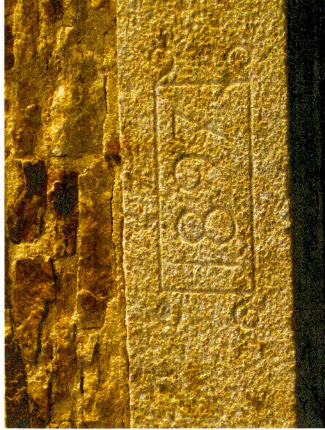
Détail du linteau de porte de la maison du jardinier (Cliché : C. Travers, 2006)
