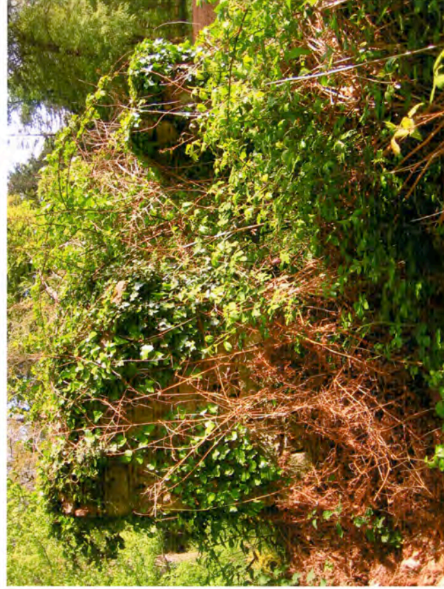
Piliers encadrant l'ouverture de l'extrémité Nord de l'ancienne terrasse des charmilles (Cliché : C. Travers, 2006)
