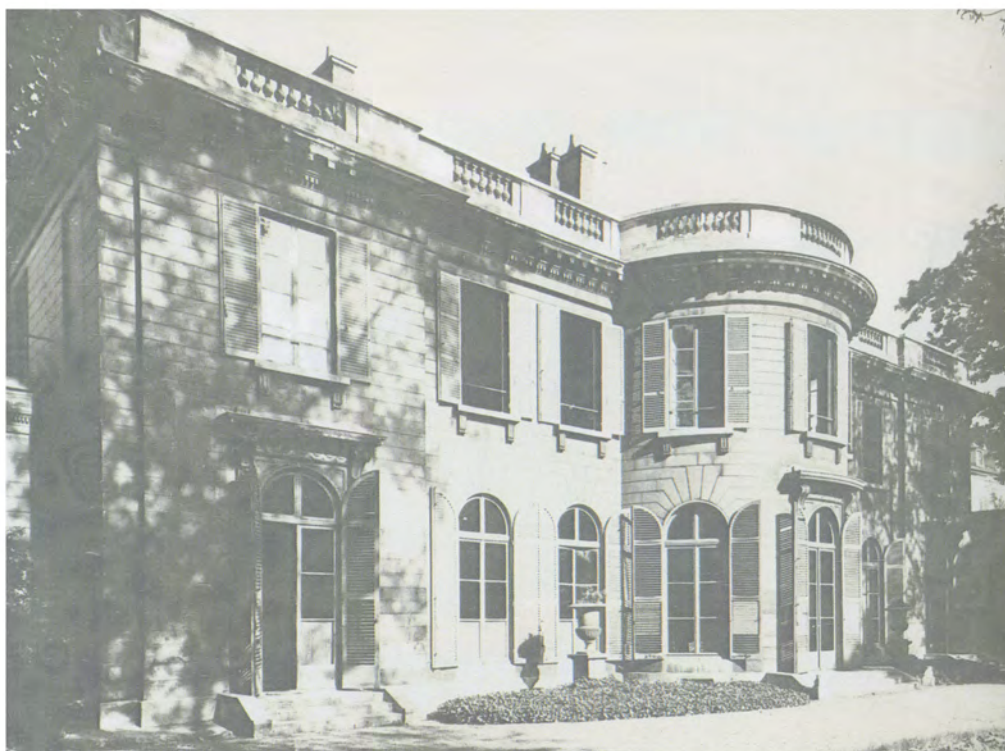
ill. 24a : RENE-JACQUES, photographe, "Façade sur jardin", 1945 (cliché GRAHAL) Bibliothèque nationale de France, Département des estampes et de la photographie, Va-274(c) Fol : VII e arrondissement, 27 e quartier, H54821
