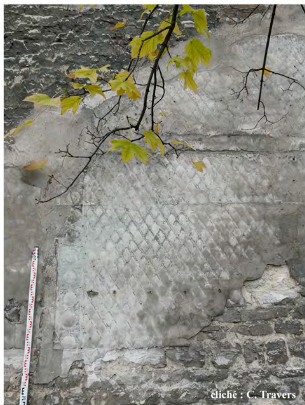
ill. 48a : Traces de treillage et de peinture sur le mur du fond du corps central de la serre XIX e
