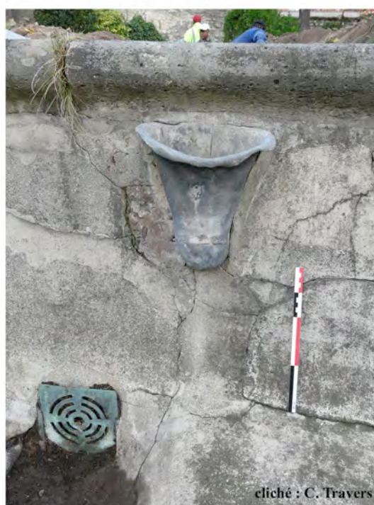
ill. 37c : Trop-plein et grille d'évacuation
