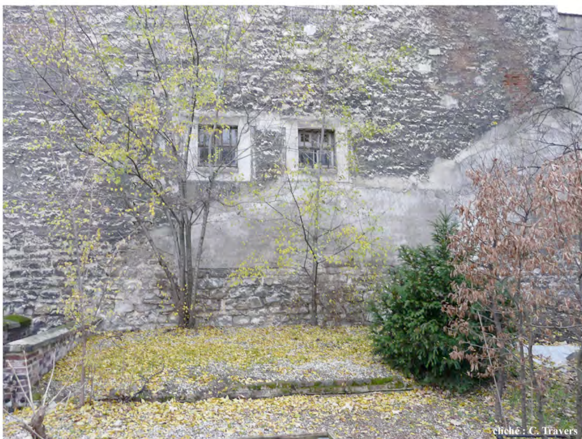
ill. 46a : Empreinte de l'aile Ouest de la serre XIXè sur le mur de clôture Nord
