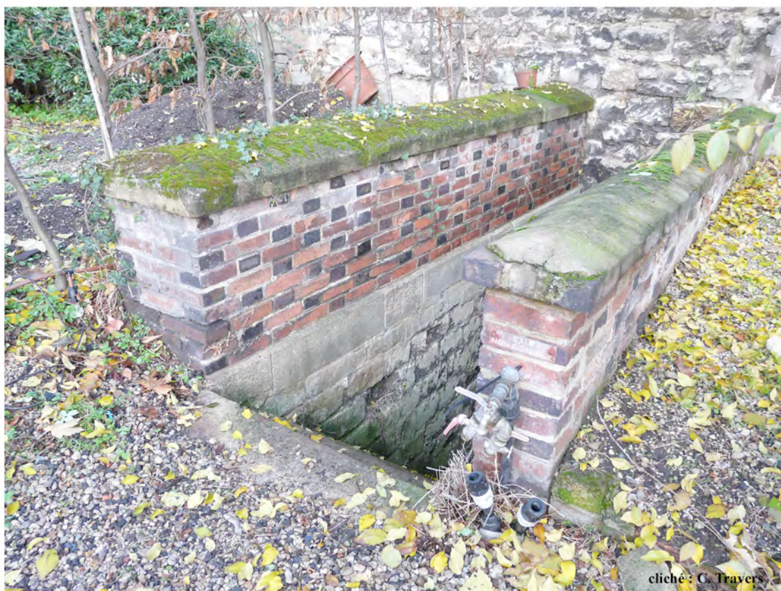
ill. 44b : Escalier XIX e permettant d'accéder au local technique souterrain
