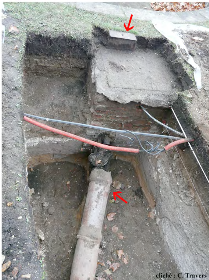
ill. 38a : Regard et tuyau de décharge du bassin XIXè
