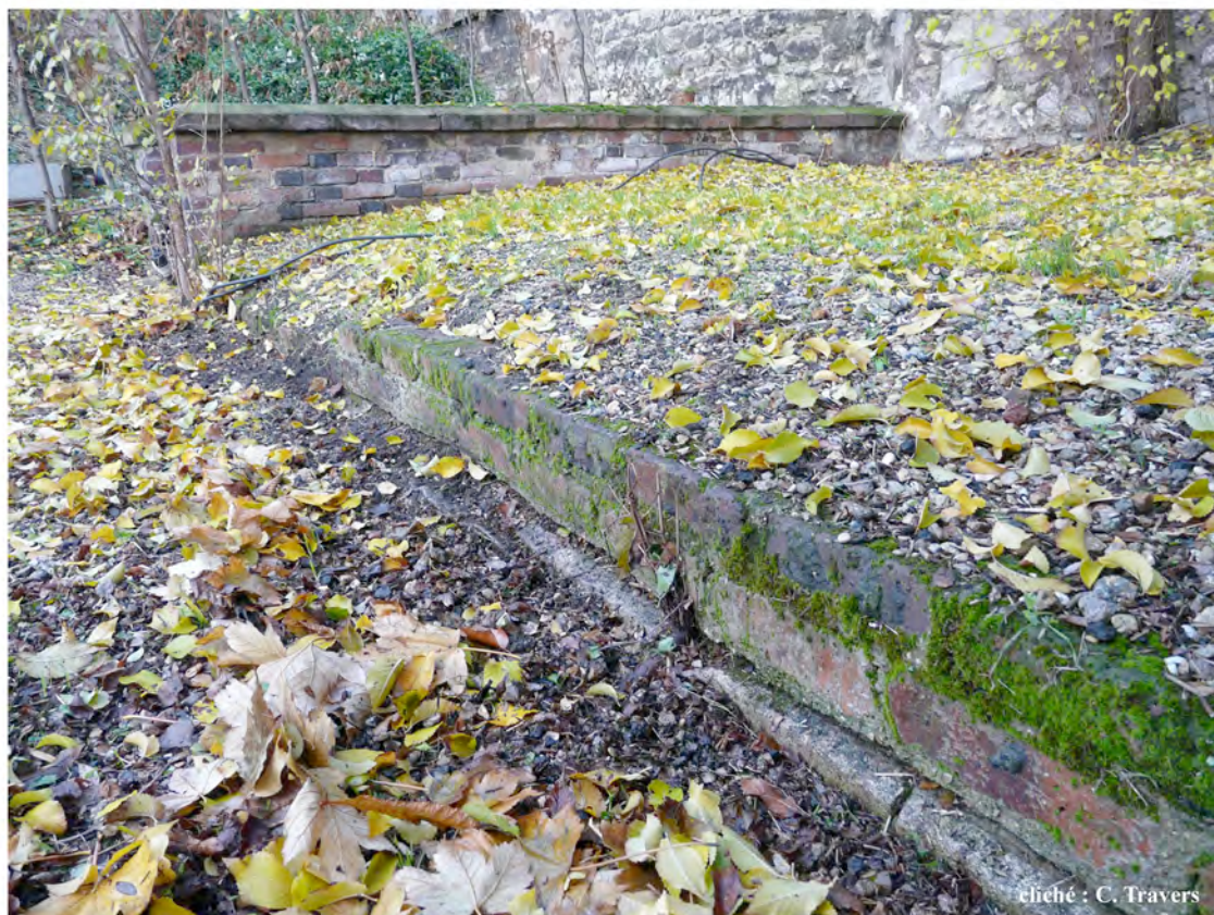
ill. 41a : Vestige d'une élévation en brique sur le soubassement en pierre affleurant
