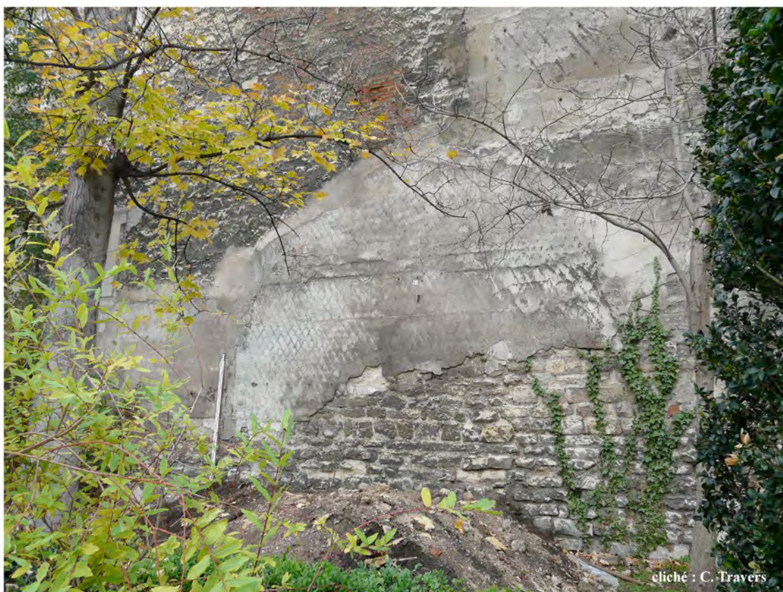
ill. 46b : Empreinte du pavillon central de la serre XIXè sur le mur de clôture Nord
