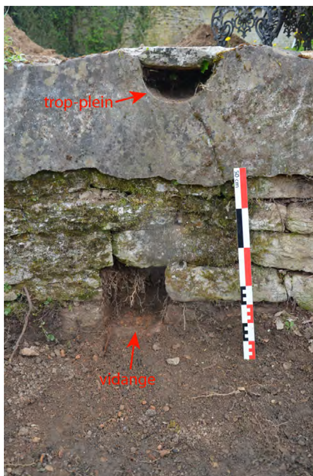
fig. 32 : Le trop-plein et la vidange du petit bassin ovale - © C. Travers
