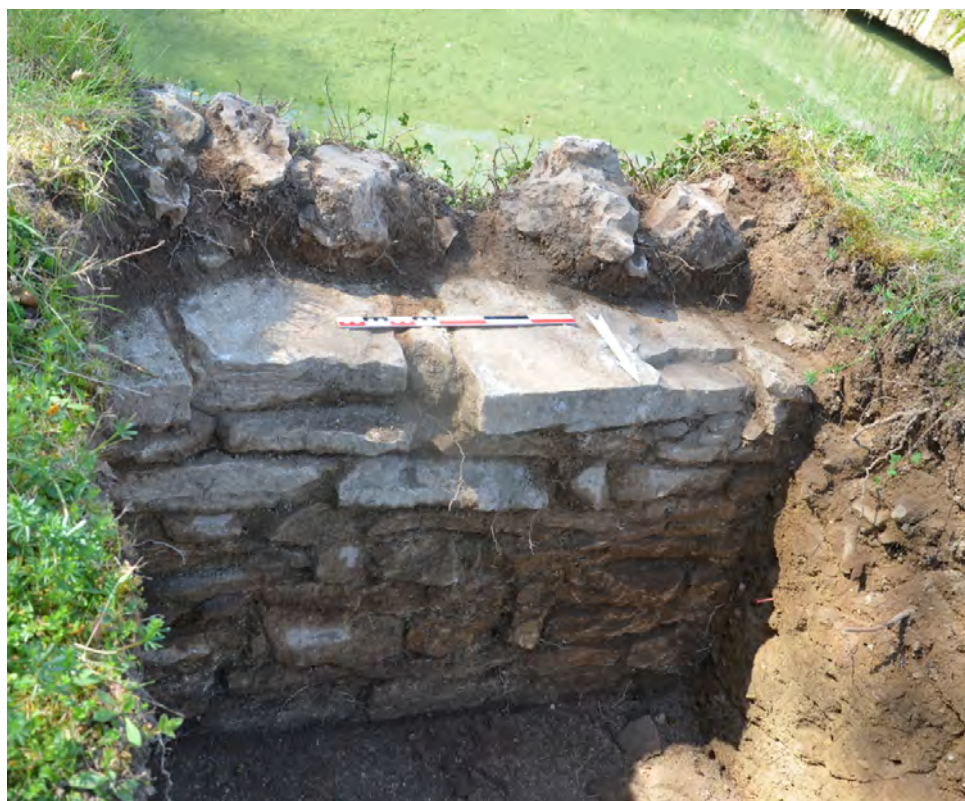
fig. 14 : Le mur nord du canal (M1) mis au jour dans le sondage S.I - © C. Travers
