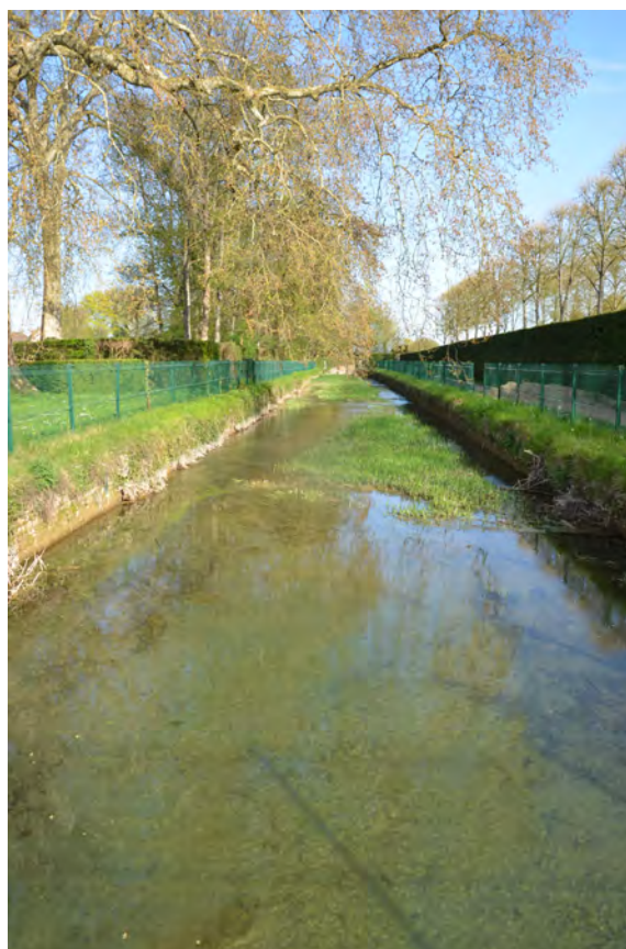
fig. 4 : Vue du canal depuis l'ouest - © C. Travers
