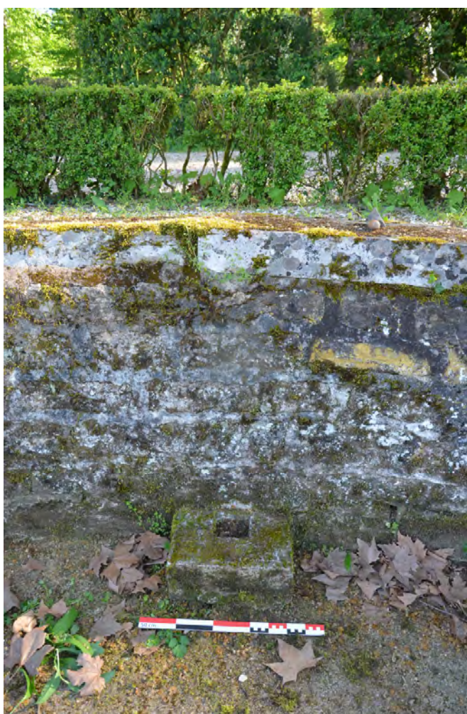
fig. 29 : Vidange du grand bassin circulaire - © C. Travers
