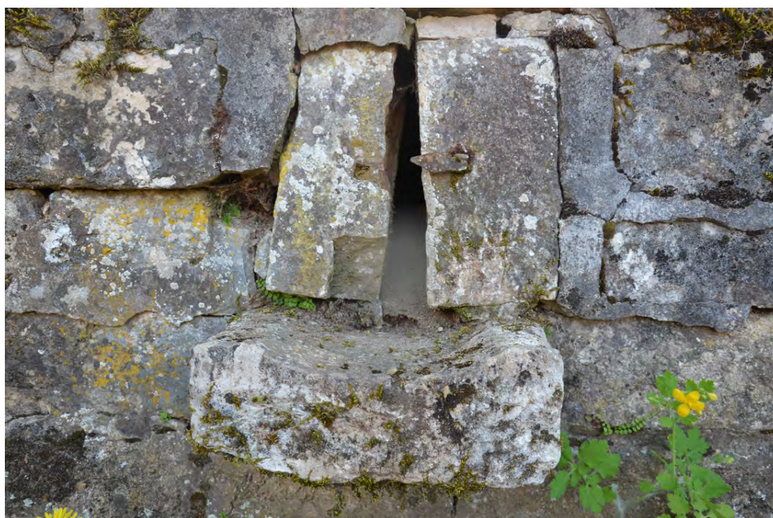
fig. 27 : Arrivée d'eau du grand bassin circulaire - © C. Travers
