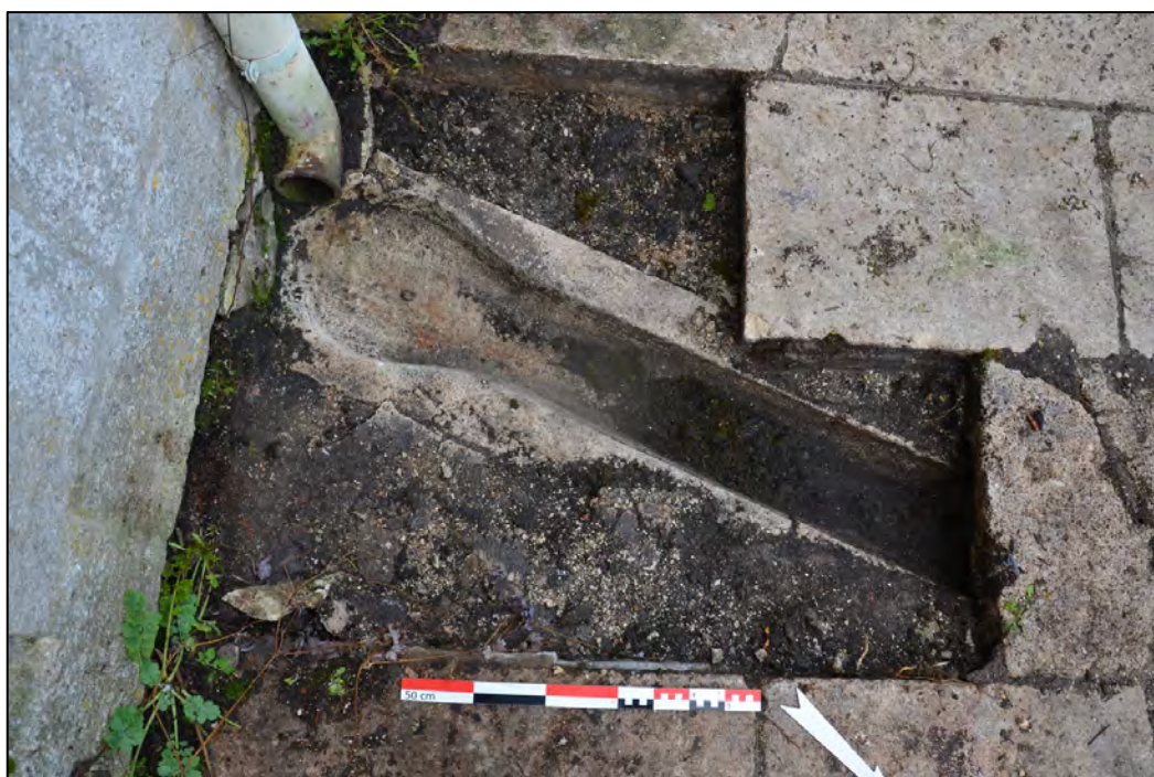
fig. 42 : Réseau de canalisations mis au jour sous les dalles de la terrasse pour l'évacuation des eaux de toiture, réceptacle au niveau du tuyau de gouttière subsistant (© C. Travers)
