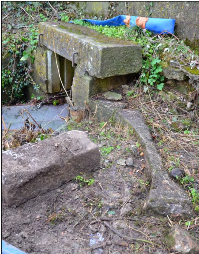
fig. 25 : Maçonnerie M5 (© C. Travers)
