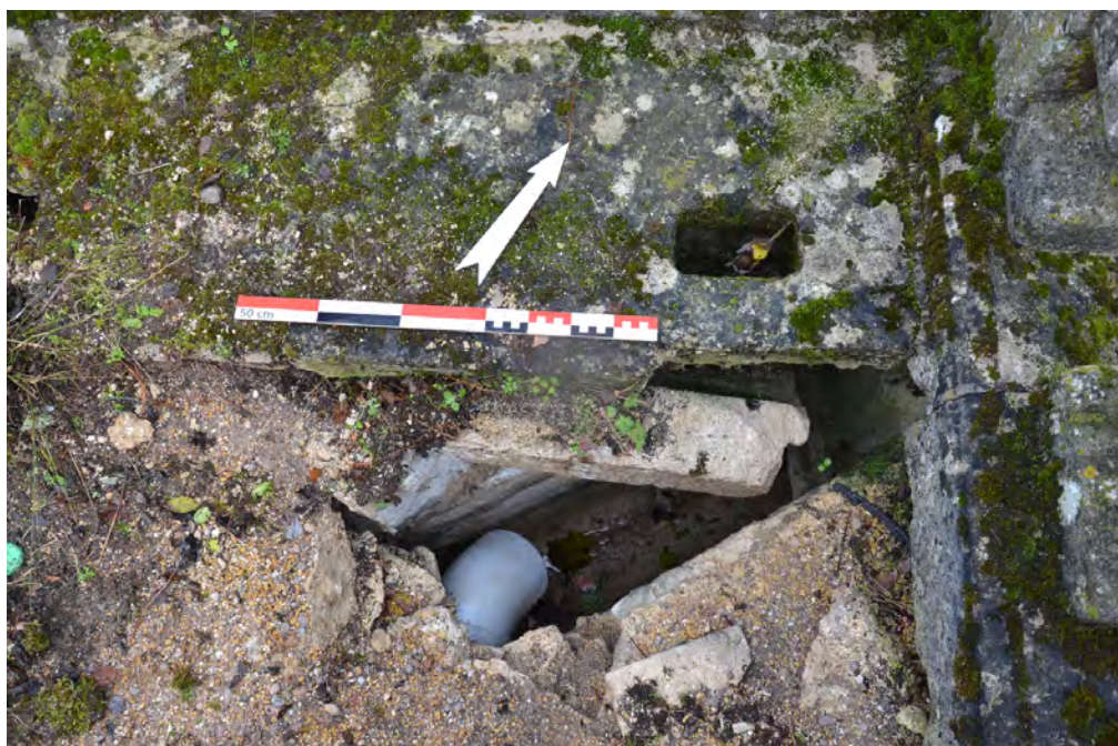
fig. 44 : Orifice pour l'évacuation des eaux coulant à la surface de la terrasse (© C. Travers)
