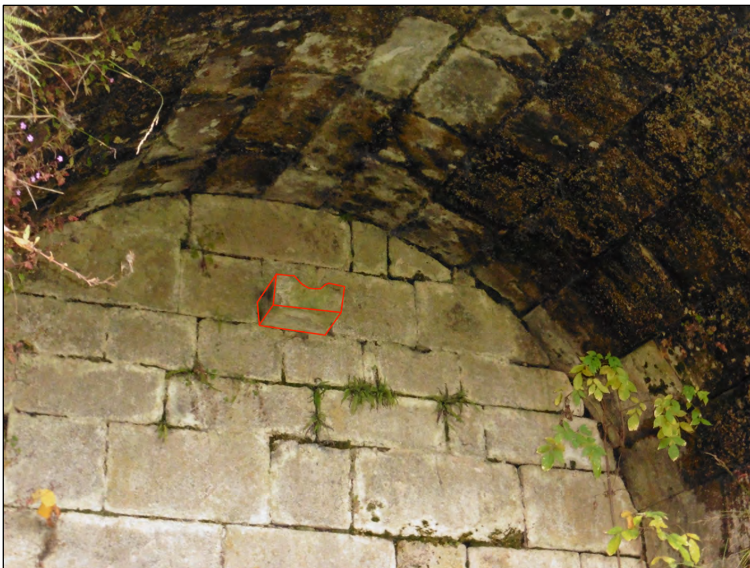
fig. 48 : Gargouille dépassant du mur de fond de l'arcade n° 2 (© Agence Caillault ACMH, DAO : C. Travers)
