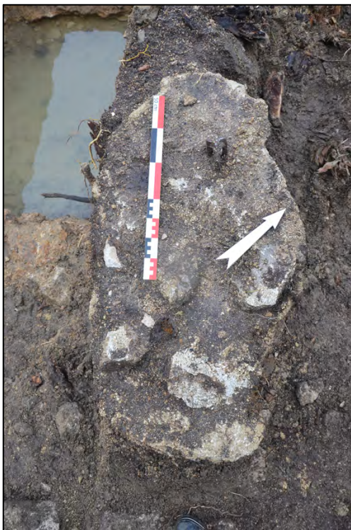
fig. 40 : Plot de fixation en béton avec « T » métallique (© C. Travers)
