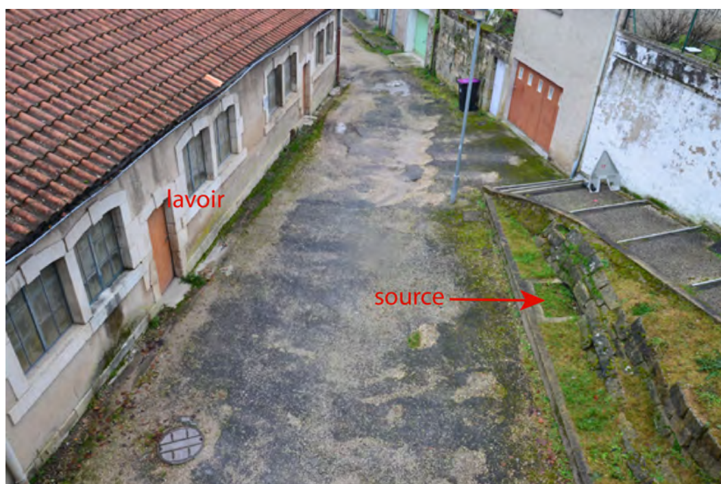
fig. 14 : Vue actuelle du réceptacle maçonné de la source de la Vierge, et du lavoir construit en 1878 (© C. Travers)
