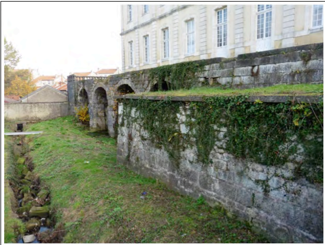
fig. 3 : Vue des éléments architecturés (terrasses, arcades et ruisseau) situés à l'arrière de l'édifice (© Agence Caillault ACMH)
