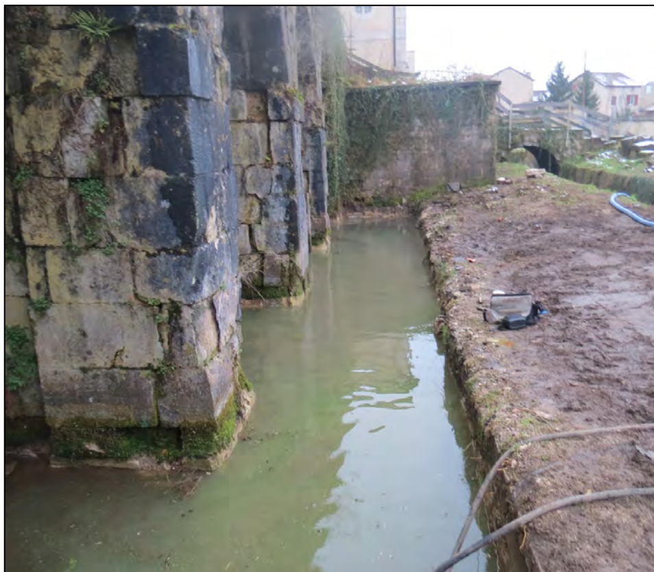
fig. 30 : Le bassin après son dégagement par la pelle mécanique (© C. Travers)
