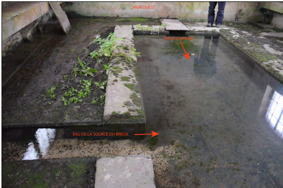
fig. 38 : Arrivées d'eau à l'intérieur du lavoir actuel (© C. Travers)
