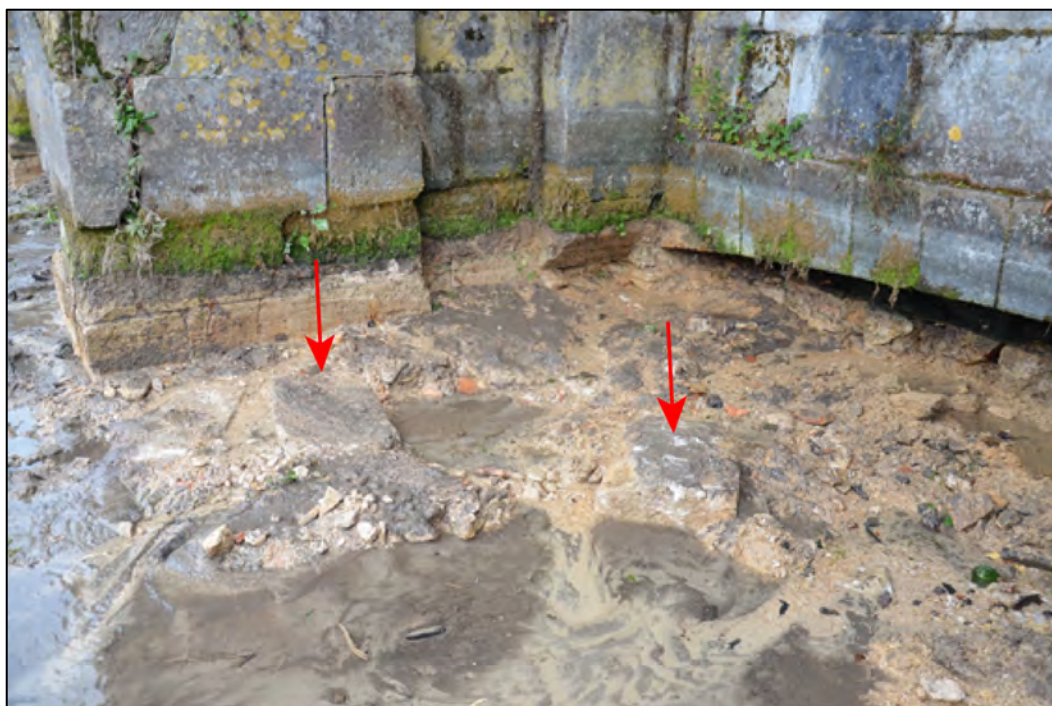
fig. 31 : Dalles en pierre reposant sur le gravier calcaire, observées au niveau de l'arcade n° 3 (© C. Travers)
