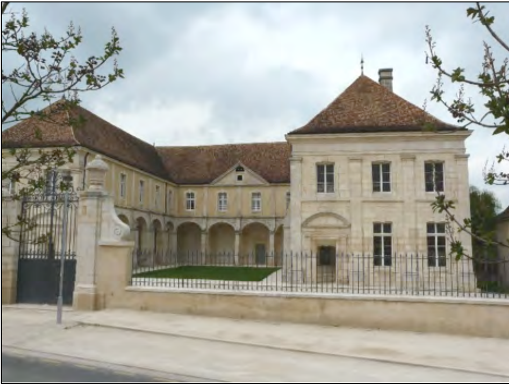
fig. 2 : Vue du prieuré après les travaux achevés en 2014 (© Agence Caillault ACMH)
