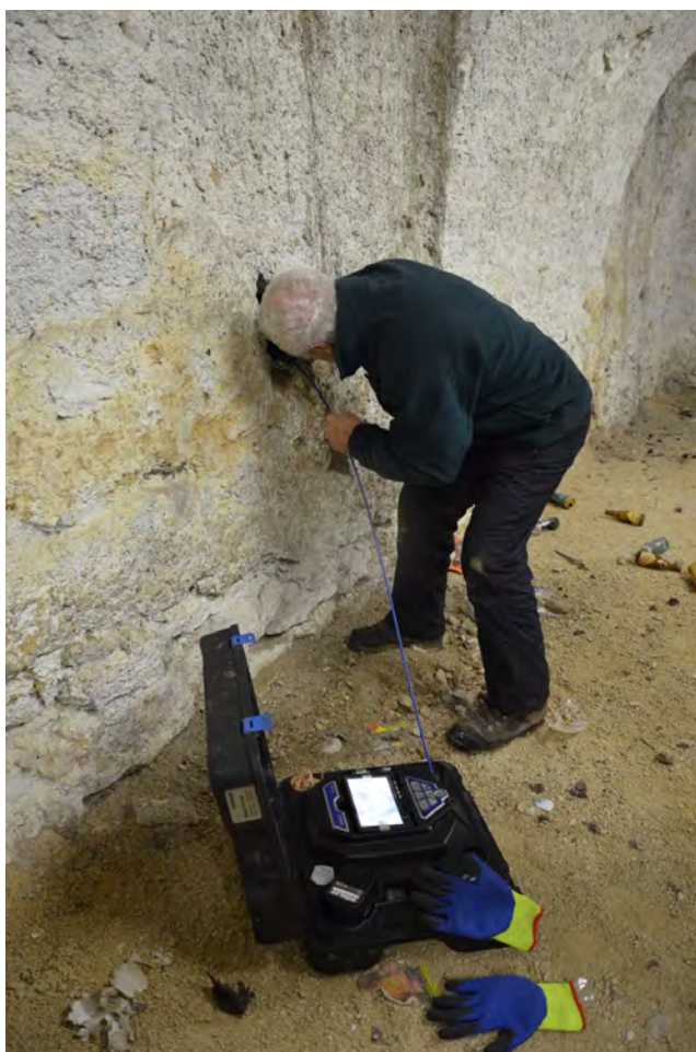
fig. 47 : Inspection du conduit d'évacuation à l'aide d'une caméra (© C. Travers)
