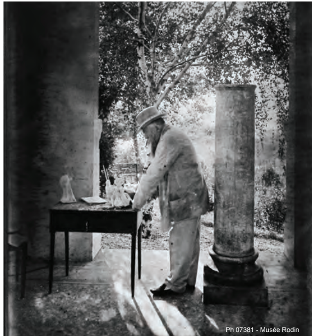
L'espace extérieur mais couvert offert par le péristyle est utilisé comme une anti-chambre de la salle d'exposition abrité par le pavillon de l'Alma.
