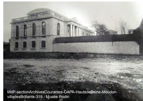
Musée édifié à l'arrière du portail du château
